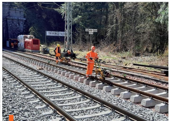
Einbau der Schienen (Verschraubung)
