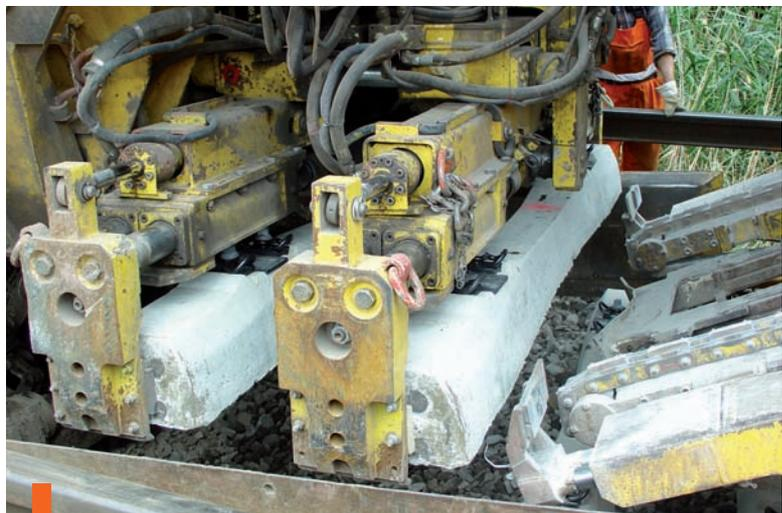
Verlegung der ZSX mit SUZ 500 UVR (Doppel-Schwellenverlegeeinheit)
